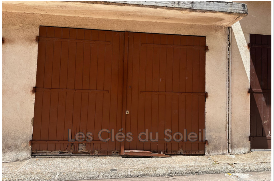
Garage extérieur 12974 Toulon
